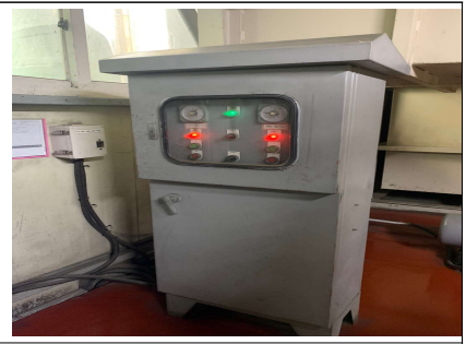
pH계, 전류계 설치 위치 (메인 제어판넬 설치)
