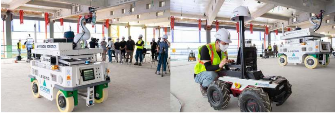
[그림 1-17] 현대건설, 양카링 자동화 로봇(좌) 및 건설현장 순찰 로봇(우)
