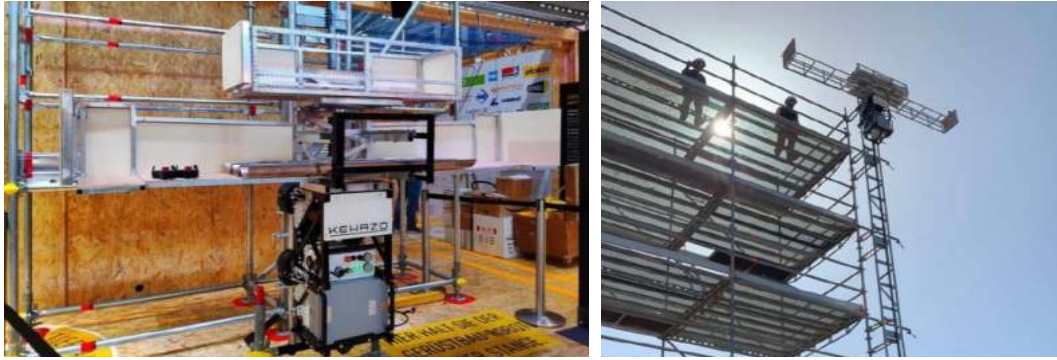
[그림 1-14] 독일의 건축 현장용 비계 조립 로봇(사진 출처: Kewazo)
