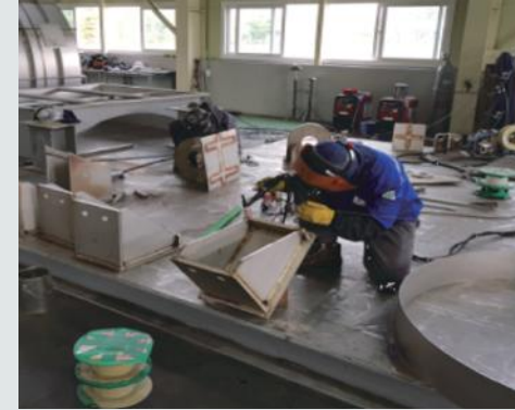
[가조립 및 용접] 소부재 부품의 가조립 및 용접
