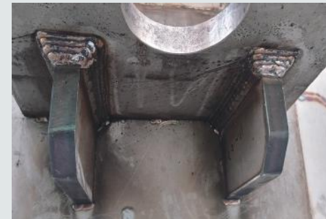
[용접] 소부재 부품의 멀티 패스 용접
