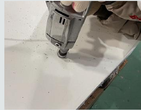
수공구로 직접 홀을 가공하므로 공수가 많고 작업이 힘들
