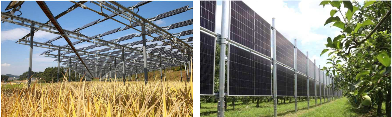
[그림] 작물 위 고정식 루프탑형(좌)과 작물 간 수직 펜스형(우) 태양광 시스템 (출처 : 한화솔루션(한화큐셀), 그랜드썬기술단)
